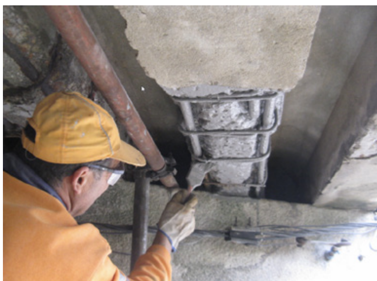
Manutenção de Obra de Arte
