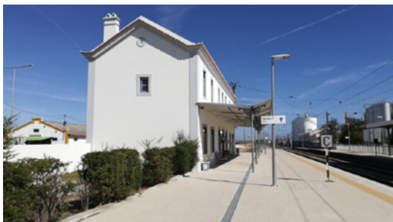
Beneficiação da estação de Riachos
