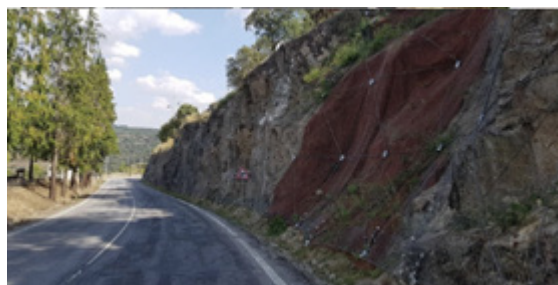
EN218 , KM 86+300 A 88+400. ESTABILIZAÇÃO DA ENCOSTA E TALUDES DE ESCAVAÇÃO
