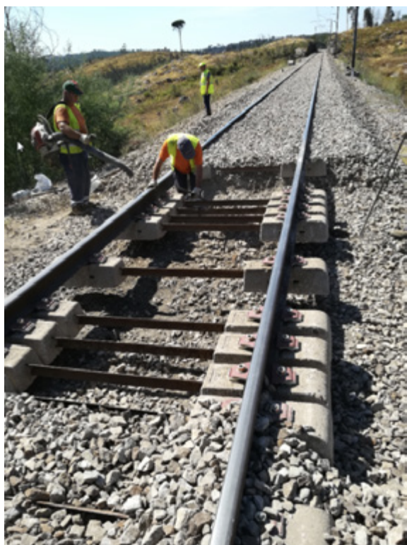
Substituição de Travessas
