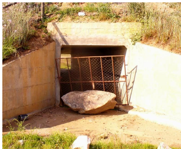
Fig. 36 – PH situada na EN256 junto do pk 32+200
