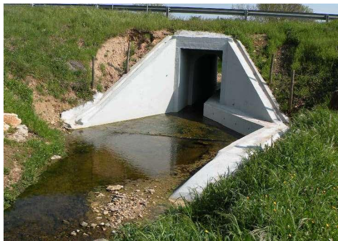
Fig. 29 – PH no IP2, próxima do pk 223, adaptada para fauna através da implementação de um passadiço.
