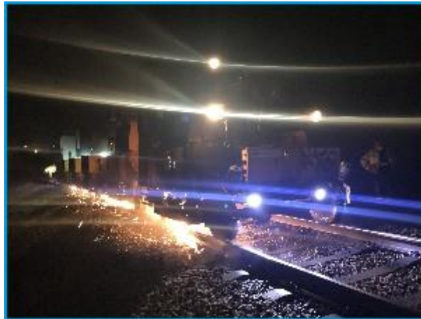
Figura 14. Esmerilagem de carris (fonte: www.fergrupo.pt ).
