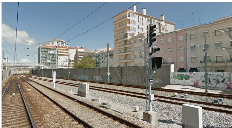
Figura 18. Barreiras acústicas na zona da Estação de Roma-Areeiro: vista a partir da linha (fonte: google maps).
