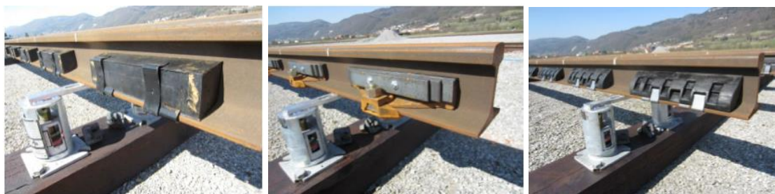
Figura 13. Atenuadores sintonizados de carril (TRD); esq. TATA/Corus, centro Schrey & Veit, direita STRAILastic_A.
