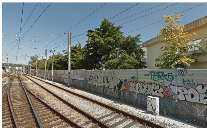
Figura 17. Barreira Acústica no troço Sete Rios-Entrecampos, na zona do Instituto Português de Oncologia.
