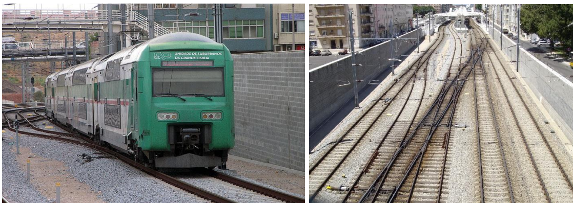
Figura 2. Comboio UQE 3500 (CP) na Linha de Cintura (esq.); via quádrupla Linha Cintura, área da estação Roma-Areeiro(dir.).
