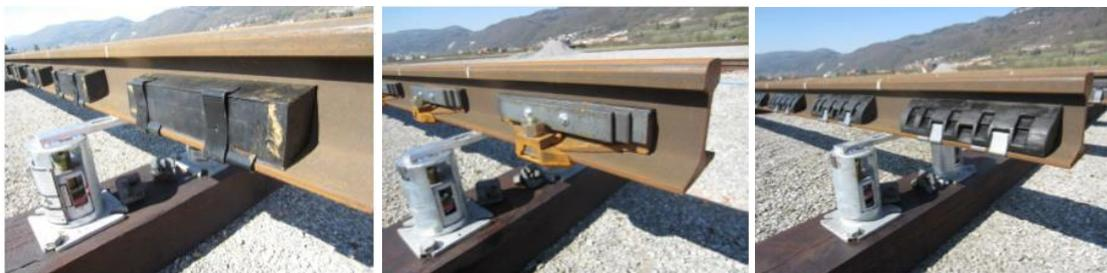
Figura 112. Atenuadores sintonizados de carril (TRD); esq. TATA/Corus, centro Schrey & Veit, direita STRAILastic\_A.
