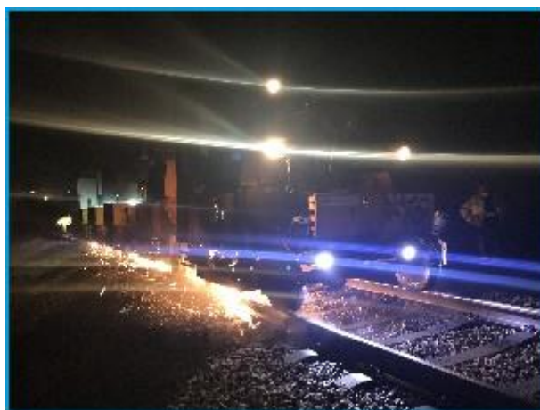
Figura 18. Esmerilagem de carris (fonte: www.fergrupo.pt ).
