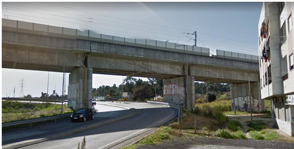
Figura 7. Viaduto da Linha do Sul I e tráfego rodoviário local na zona do Fogueteiro. Note-se a existência de barreira acústica aplicada ao viaduto ferroviário (fonte: google maps).
