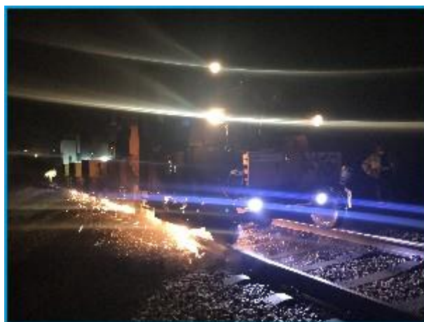
Figura 20. Esmerilagem de carris (fonte: www.fergrupo.pt ).
