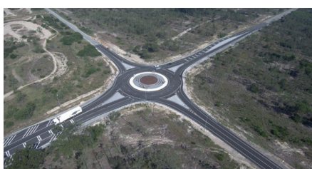
Antes da Intervenção
