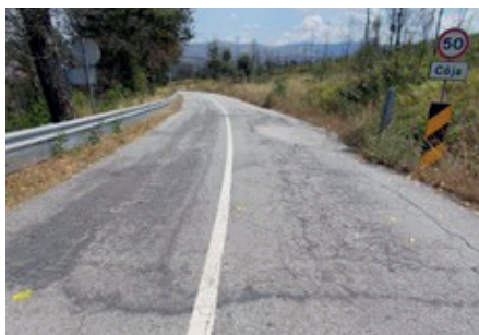
Antes da Intervenção
