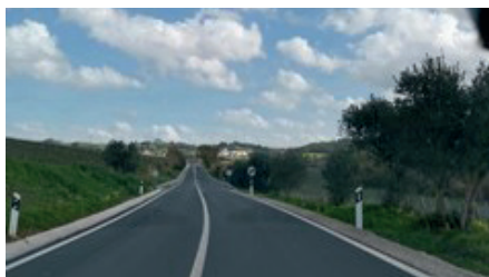
Depois da Intervenção
