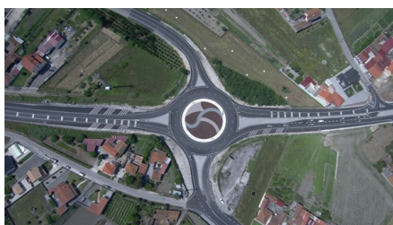
Depois da Intervenção
