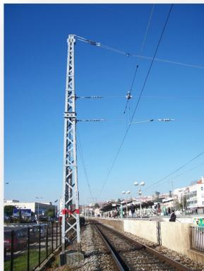
A ação teve como objetivo a reparação e pintura de postes de catenária que, nesta linha, pela proximidade ao mar, estão particularmente expostos a condições que proporcionam uma degradação e corrosão acentuada dos materiais.
